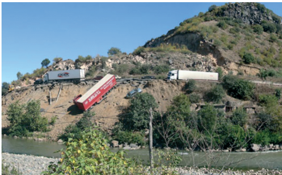
Նկար 28. Ալավերդի-Նոյեմբերյան մայրուղու սողանքը 2013թ.
