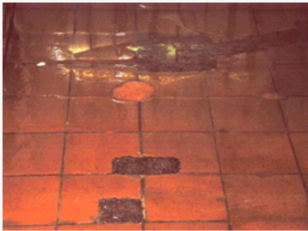
Բացակայող սալիկներ, ոչ հիգիենիկ ջրահեռացման համակարգ, ջուրը հոսում է հատակի վրայով
