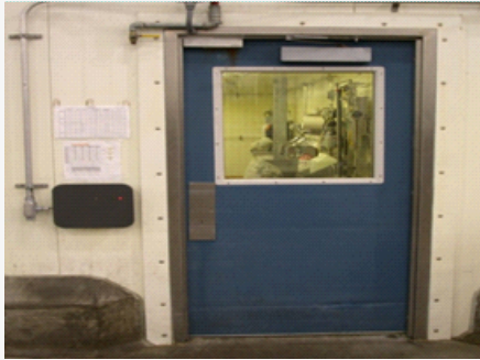
Ավտոմատ փակվող դռներ՝ կեղտոտ և մաքուր սենյակների բաժանում (այսպես կոչված ակտիվ հսկողություն)
